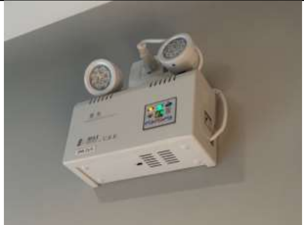
ภาพที่ 60 ไฟฉุกเฉินตามชั้นพักอาศัย
